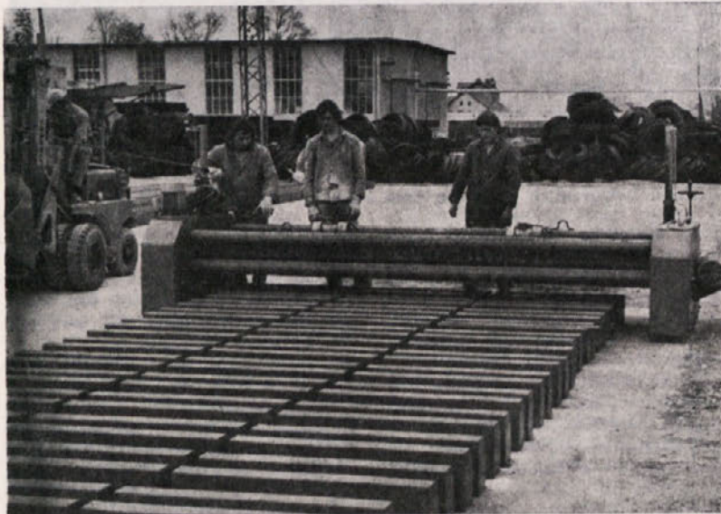
Sodobna proizvodnja betonskih cestnih robnikov
