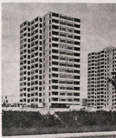
16-etažne stolpnice iz modularnih armiranobetonskih elementov v eni izmed sosesk
