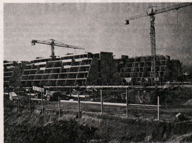
Stanovanjski bloki »Koseze« Ljubljana so terasasti, prizmatičnega prereza. V enem objektu je 40 stanovanj, skupno neto stanova-njske površine 3596 m 2 . Sistem gradnje je liti beton s toplotno za-ščito Dryvit.
