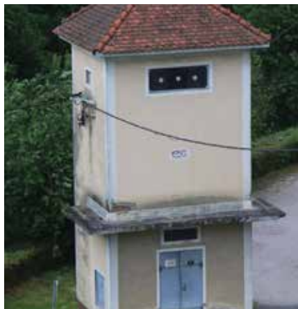
Transformator Gornja Radgona pred obnovo
