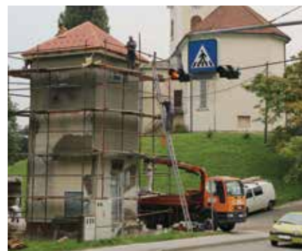
Obnova transformatorja Gornja Radgona
