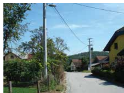
TP Lončarovci in NN omrežje po obnovi
