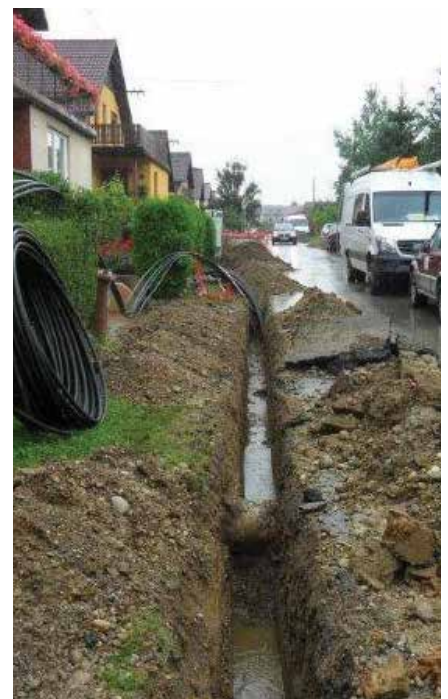
Priprava jarka za položitev kablovoda
