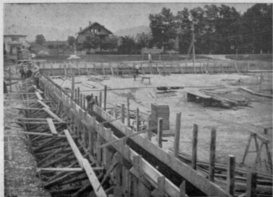
Na gradbišču celjskega ljudskega kopališča dela hitro napredujejo.
