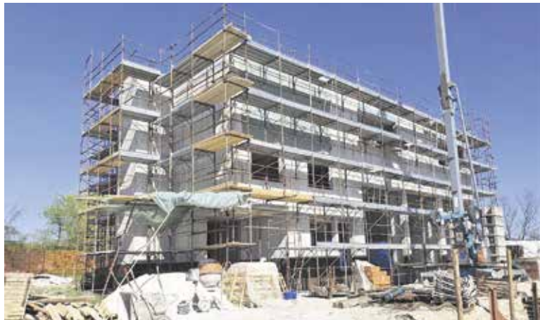
V gradnji je Dom Kranjnov Študa, ki bo tudi energetska varčna stavba.
