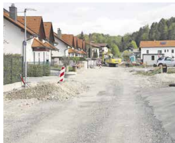
Dela na Opekarniški cesti
