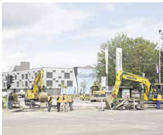
Začetek del na Masljevi ulici v Domžalah
