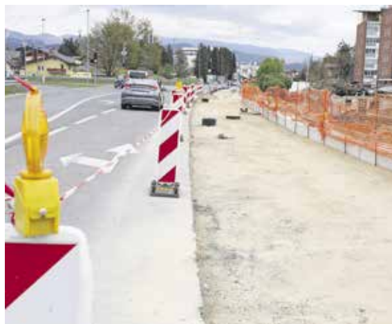
Gradnja Regionalne kolesarske povezave
