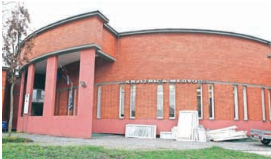
Novembra so začeli menjati stavbno pohištvo na Knjižnici Medvode.
