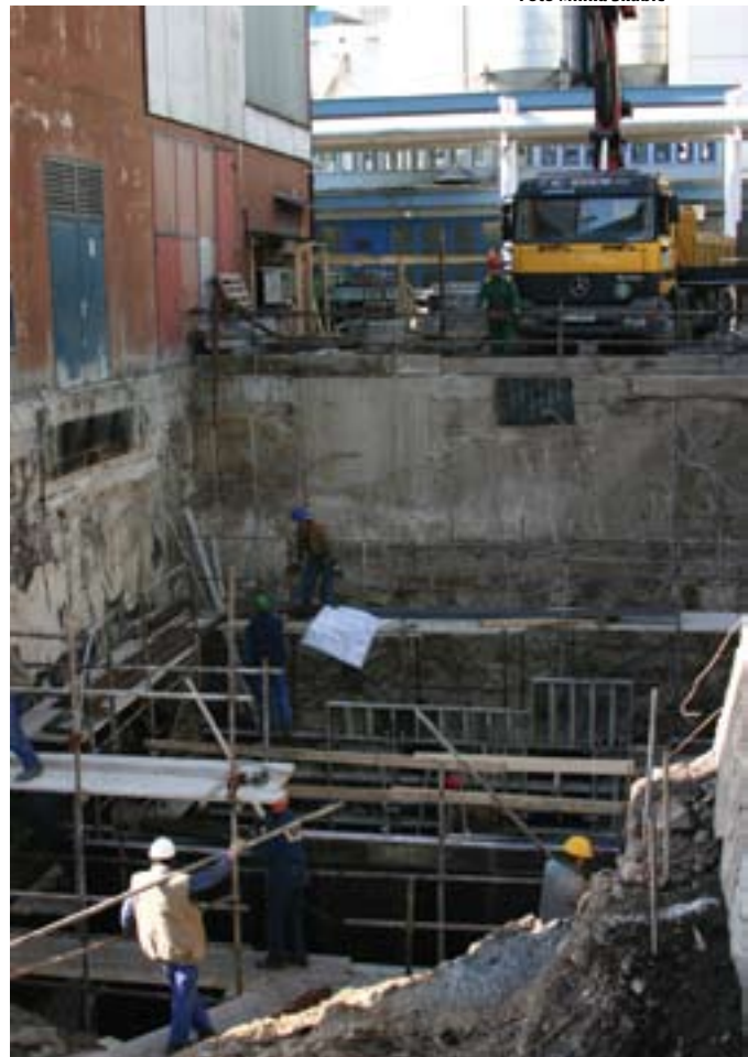
Dela na vsipniku biomase so v polnem teku.
