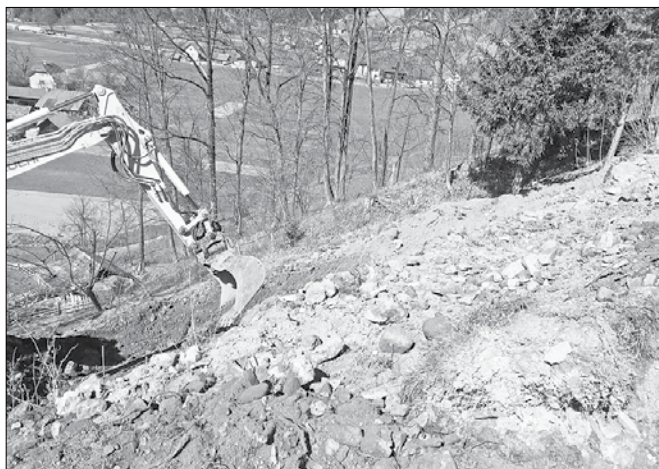
Prenova opornega zidu ob poti na pokopališče Rosulje (foto: Radenko Tešanović)
