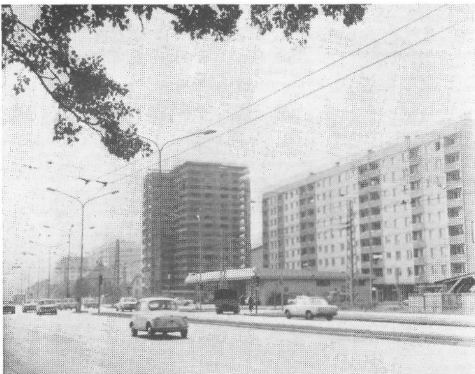
Novogradnje ob Celovski cesti
