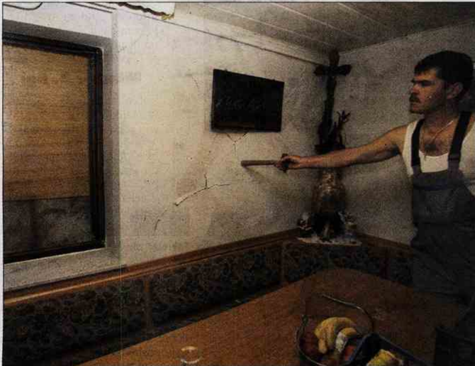
Najmočnejši udarni val je poškodoval kuhinjsko steno.
