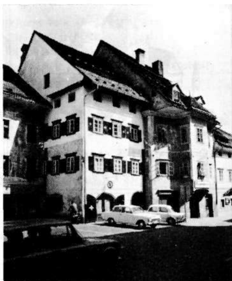
Obnovljeno pročelje Martinčkov hiše na Mestnem trgu v Škofji Loki. (Foto Aki.)
