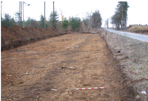
22 Jarki 1–4 v sektorju 2; jarka 1 in 4 sta na skrajnem desnem in levem robu izkopnega polja, pogled proti vzhodu.
