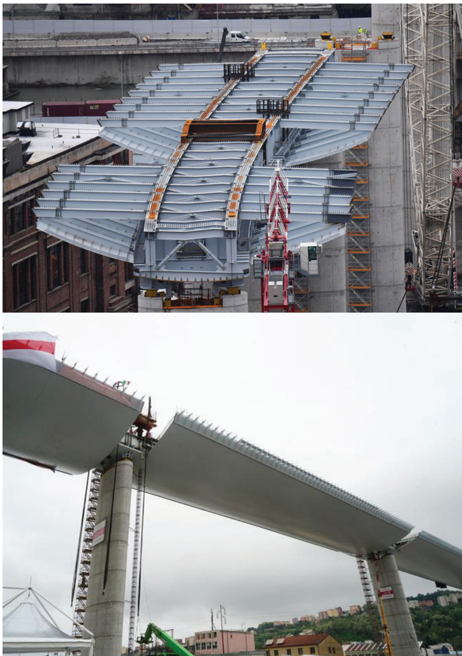
Slika 4 • Nov avtocestni viadukt v Genovi, 2020 (Corriere Della Sera, 2020).
