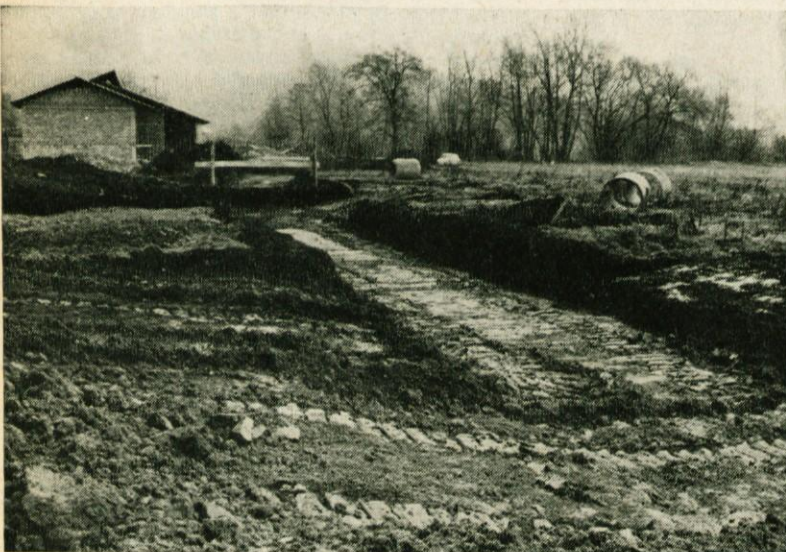
»BIRO 71« ureja v Šlandrovi ulici 8 gradbenih parcel. Kupci bodo kupili komunalno urejena zemljišča.
