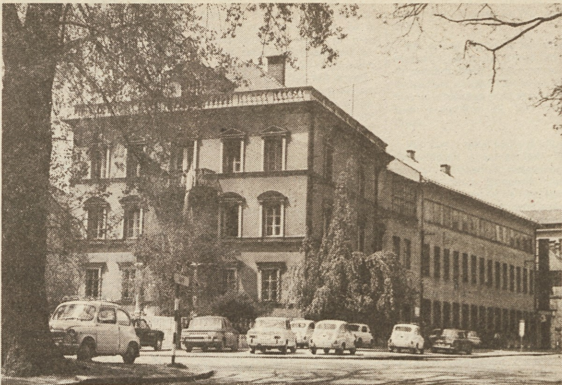
Mercatorjeva upravna zgradba v kareju, ki ga z vzhodnih strani tvorijo ulice Emonska, Aškerčeva in Kardeljeva. Blivša Jelačinova vila. Fotoarhiv.
