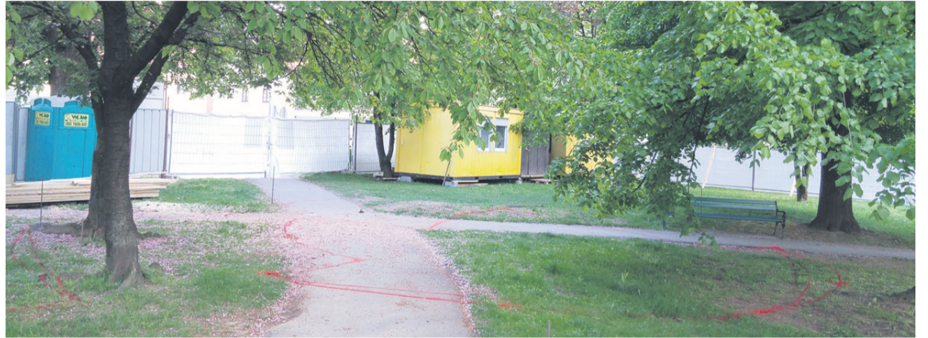
Podobno skrivnostni kot so bili v Žalcu pri snovanju projekta fontane zelenega zlata bodo, kot kaže, tudi pri gradnji. Območje so namreč povsem zaprli, tako da lahko radovedneži, ki bi želeli spremljati gradnjo enega najodmevnejših projektov v občini v zadnjih letih, na gradbišče kukajo le skozi špranje. Kot je videti, dreves na tem območju še niso odstranili, so pa na tla zarisali prve obrise.
