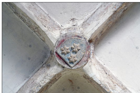
30. Slovenske Konjice, župnijska cerkev sv. Jurija, severna kapela, stik sklepnika z rebri v tretji traveji (© ZRC SAZU, foto: Andrej Furlan)
