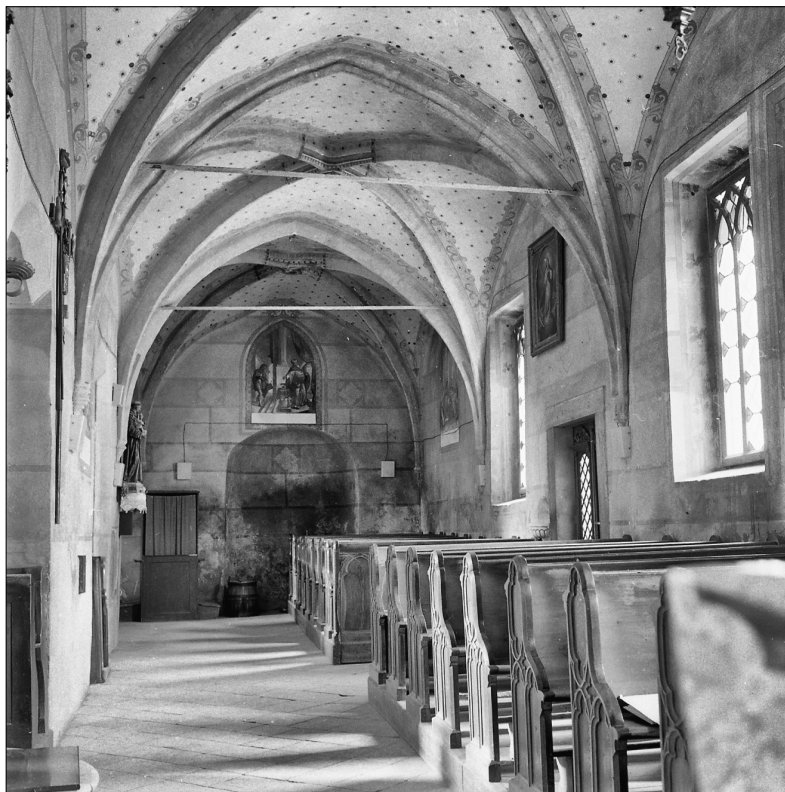
13. Slovenske Konjice, župnijska cerkev sv. Jurija, severna kapela, pogled proti zahodu pred obnovo v sedemdesetih letih (© ZVKDS, OE Celje)
