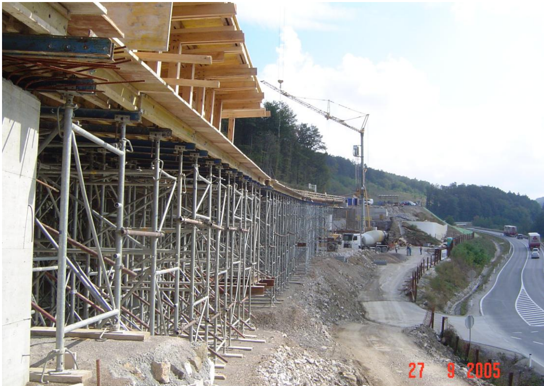
Slika 1.25: Primer prostorskega paličja, ki je predstavljalo nosilno konstrukcijo opaža pri gradnji viadukta Boršt 1 pri Vipavi
