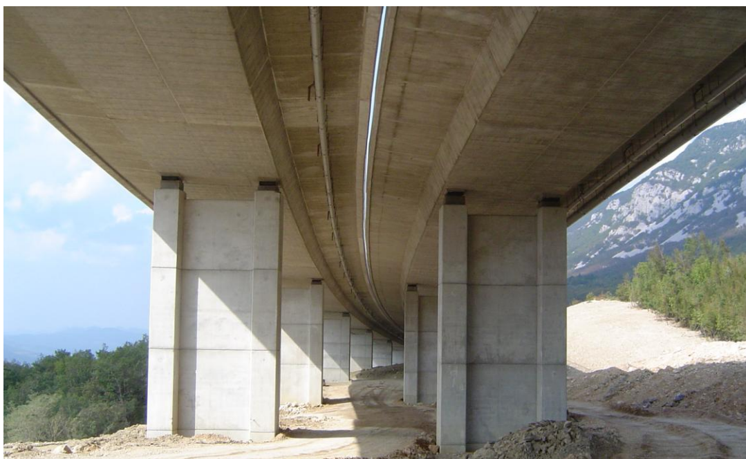
Slika 1.23: Prekladna konstrukcija (plošča spremenljive debeline) viadukta Šumljak
