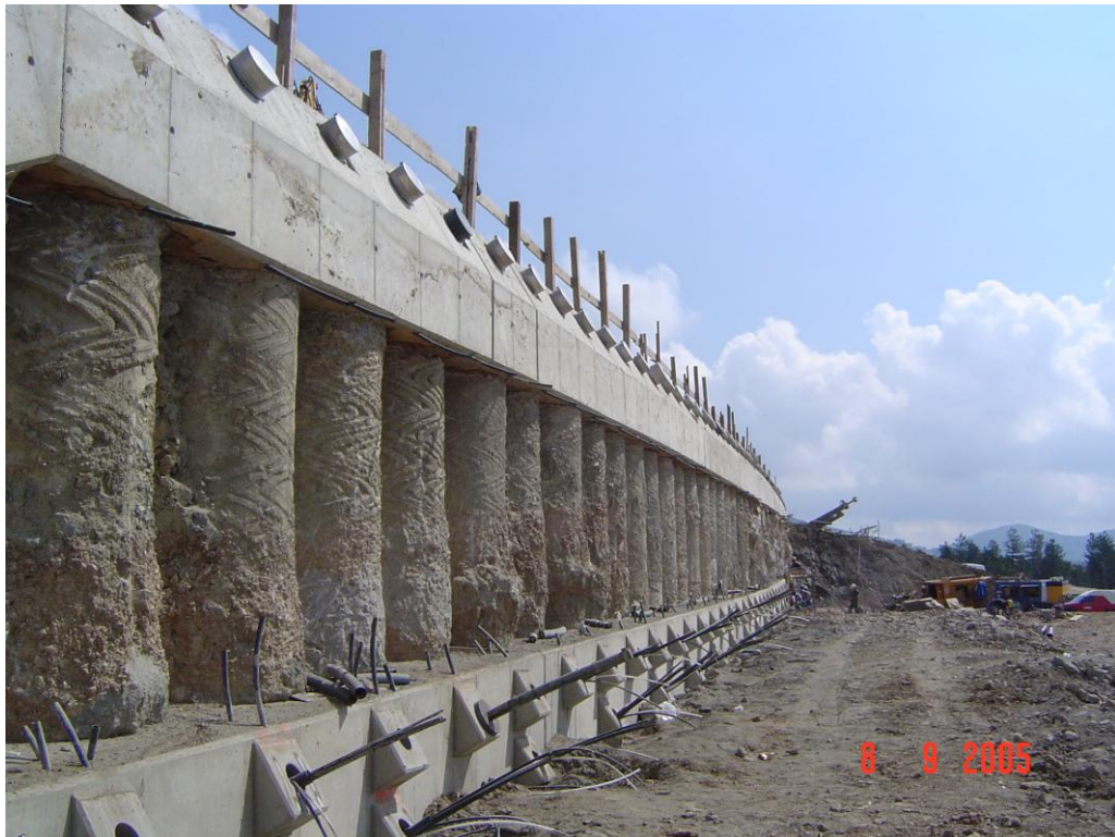
Slika 1.26: Realna konstrukcija sestavljena iz linijskih elementov – pilotna stena OZ 10 na AC Razdrto - Vipava
