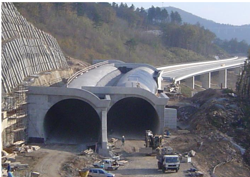
Slika 1.21: Lupinasta konstrukcija dvopasovnega pokritega vkopa Rebernice 1
