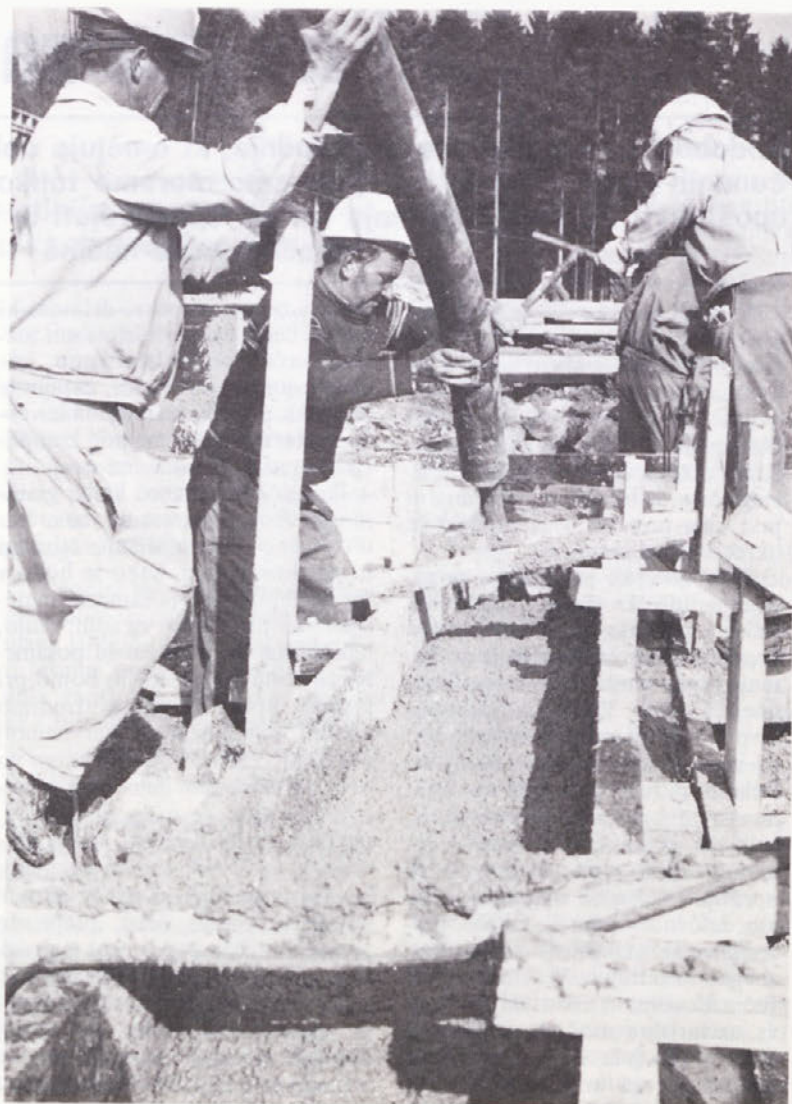
Cev betonske avtočrpalke so namestili nad opaž in zdaj avtočrpalka dobesedno bruha beton vanj
