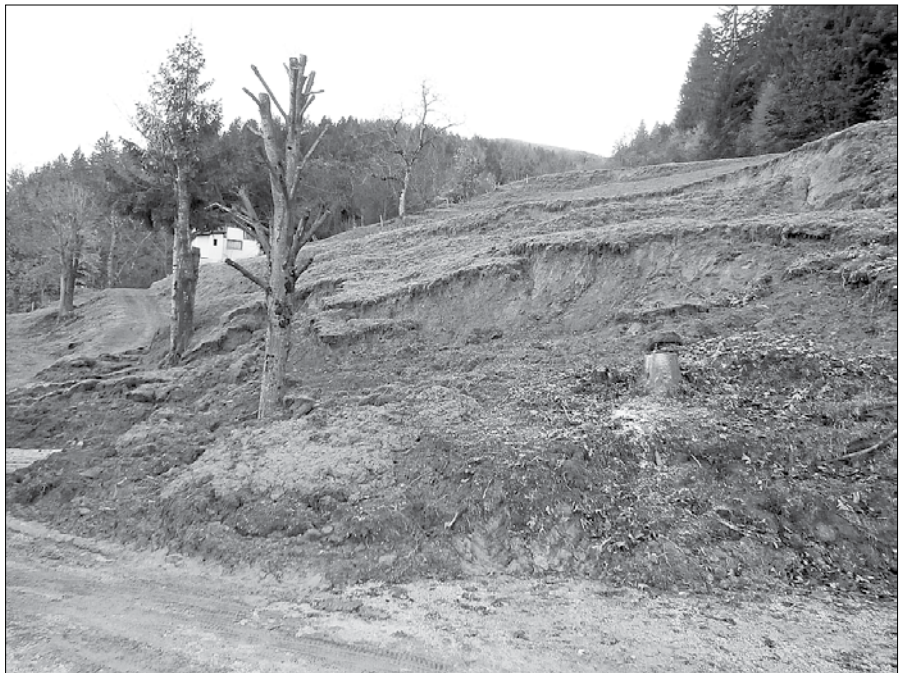
Plaz Slapnik, ki v Rovtu ogroža hiše. (Fotodokumentacija KS Šmartno ob Dreti)
