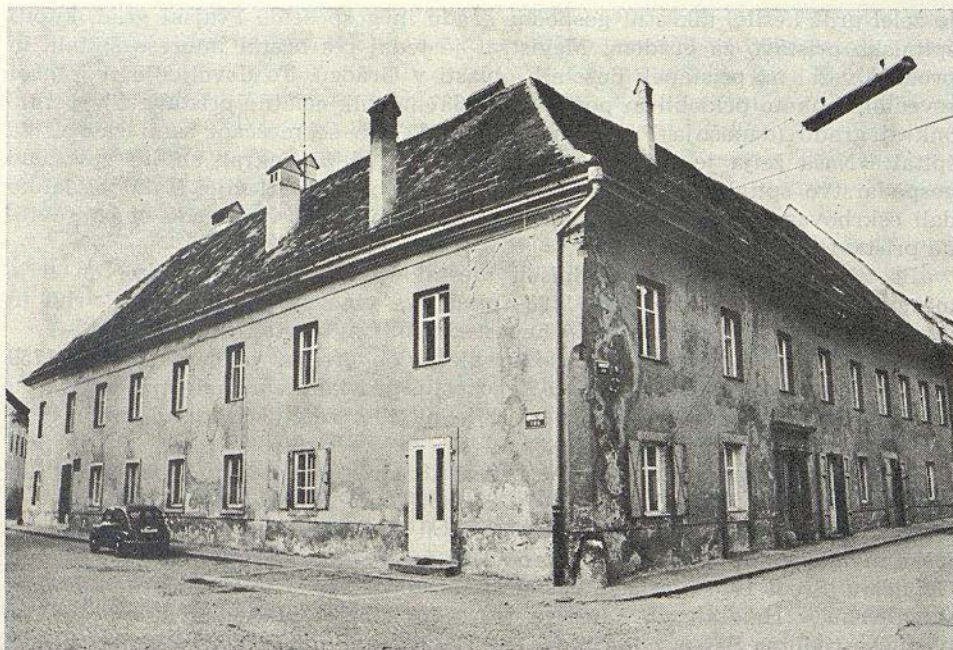
Slika 1: Stavba nekdanjega meščanskega špitala v Ptuj
