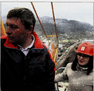
Cvetko Heriah je kot izkušen gradbenec Petra za delo na gradbišču dodatno navdušil.
