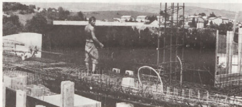
Še malo, pa bodo armaturno mrežo na vrhni plošči stavbe Ljubljanske banke zalili z betonom
