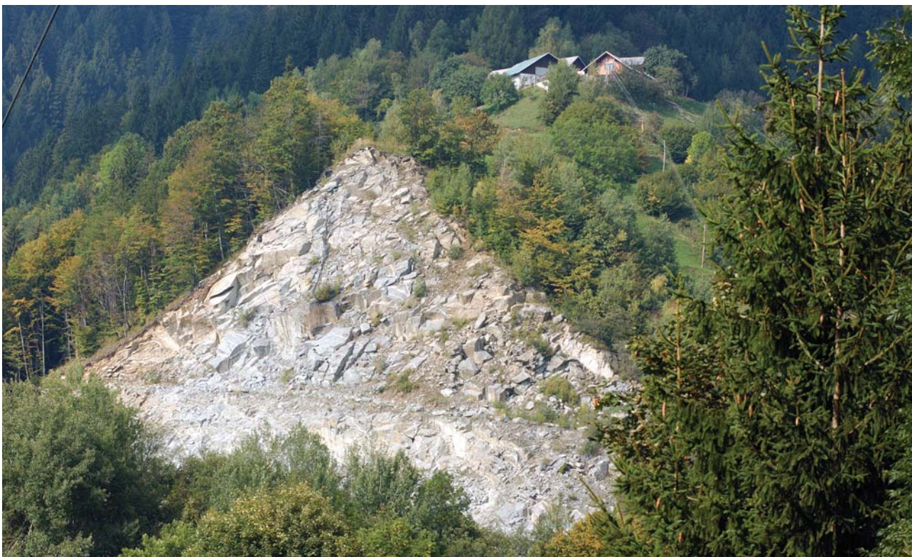
Slika 1: Kamnolom Cezlak I se je že nevarno približal kmetiji nad njim, zato je nadaljnje pridobivanje kamna horizontalno omejeno (foto: Domen Grögl).
