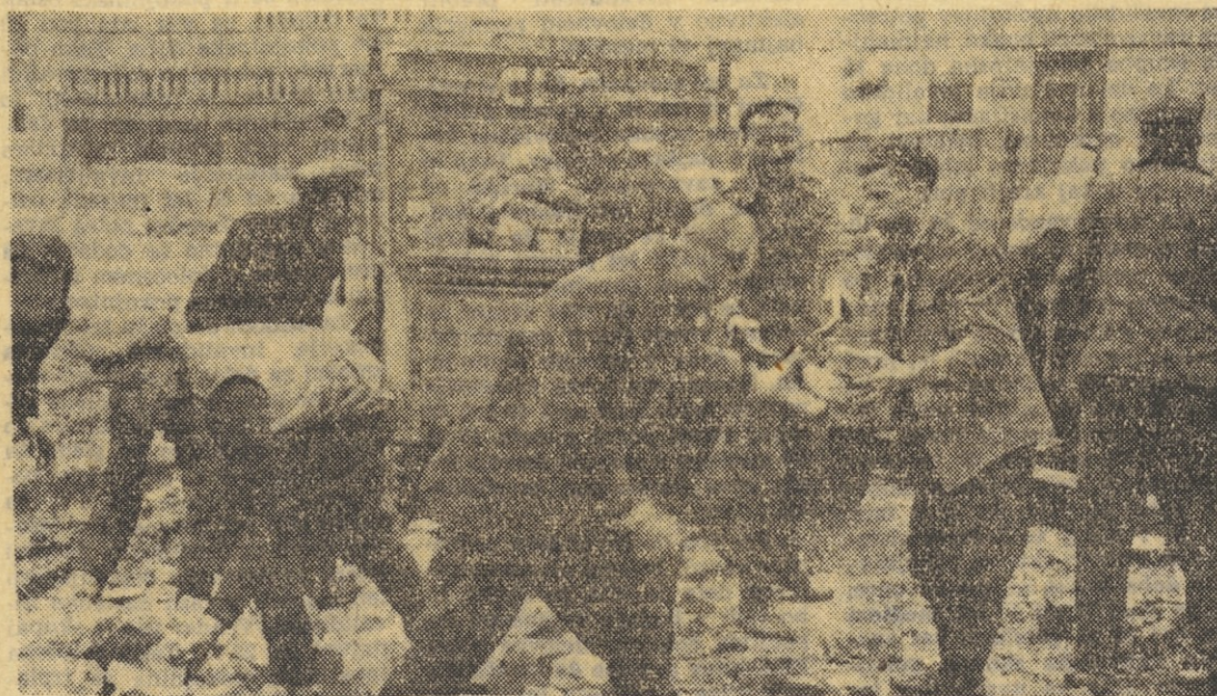
Tudi dež jih ne ovira. Gradbena sezona je pred vrati, zato je treba pohiteti in čimprej pripraviti teren za nove stanovanjske gradnje
