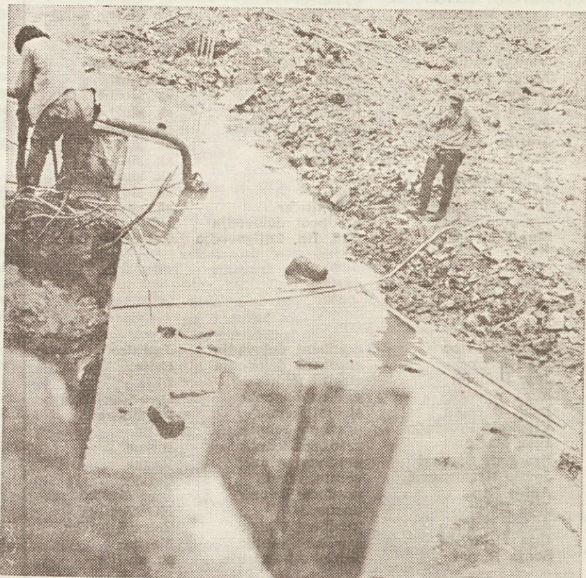
Pri gradnji na Bernardinu je velika ovira morska voda
