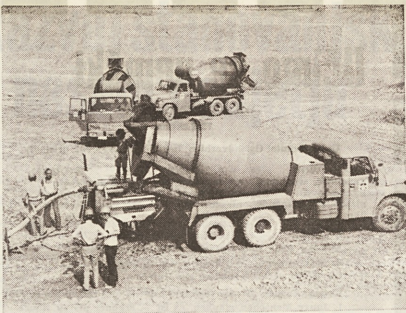
Betoniranje se vrši tudi z betonsko črpalko kateri služi kar več »raketa«
