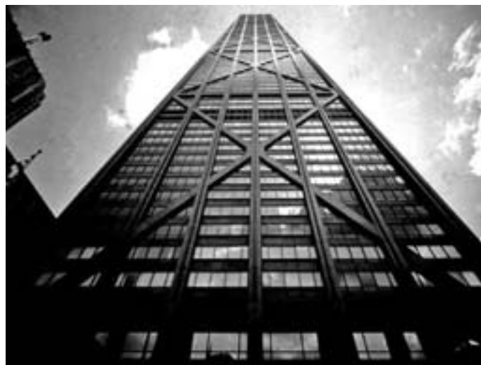
Slika 6: Primer dejanske in vidno izražene konstrukcijske odpornosti na horizontalne (potresne) obremenitve: stavba Hancock v Chicagu s tektonsko obliko (trapezoid) in z vidnimi diagonalami preko fasade. [vir: www.greatbuildings.com/buildings/John_Hancock_Center.html ].
