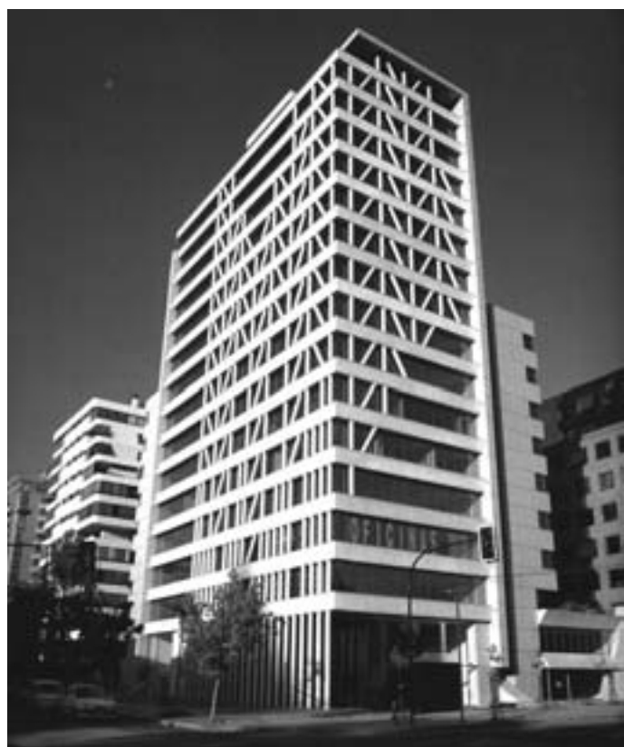
Slika 7: Dva primera dejanske in vidno izražene konstrukcijske odpornosti na horizontalne (potresne) obremenitve: Wool House v Wellingtonu in stavba Union House v Aucklandu z dodanimi ojačitvenimi diagonalami. [vir: Charleson, 2000 in www.rcp.co.nz/project-union-house.php ].
