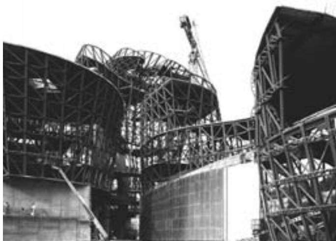
Slika 5: Konstrukcija muzeja Guggenheim v Bilbao zgolj sledi arhitekturni zamisli, ki je popolnoma formalistična in likovna. Konstrukcija vpliva na arhitekturo nima in ji je tudi v celoti podrejena. V končni obliki je konstrukcija povsem prikrita s fasado. [vir: Lyall, 2002].
