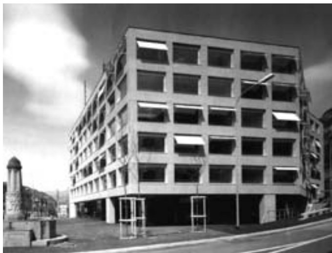
Slika 4: Objekt stoji z dokazanim izračunom inženirja, vendar gre z vidika potresne varnosti za zgrešeno zasnovo in namerno uvajanje t.i. "mehke etaže". [vir: A10, št. 13/2007].
