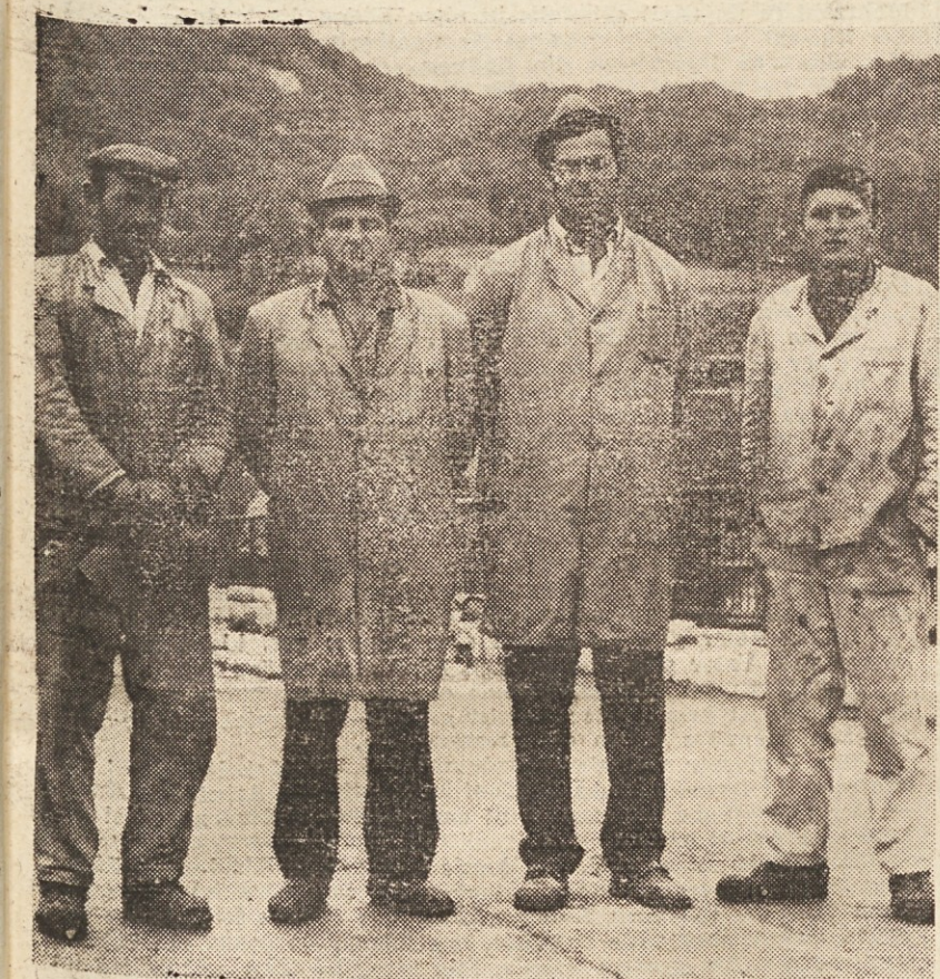
V objektiv naše kamere smo med delom na novem mostu ujeli strojnika Nikolo Mihaliča, šefa gradbišča Ivana Rateja, delovodjo Jožeta Štuhca in ključavničarja Boškota Surlo
