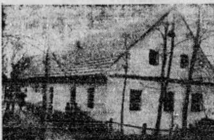
Dom Antona Mraka v Stanežicah pri št. Vidu nad Ljubljano.
