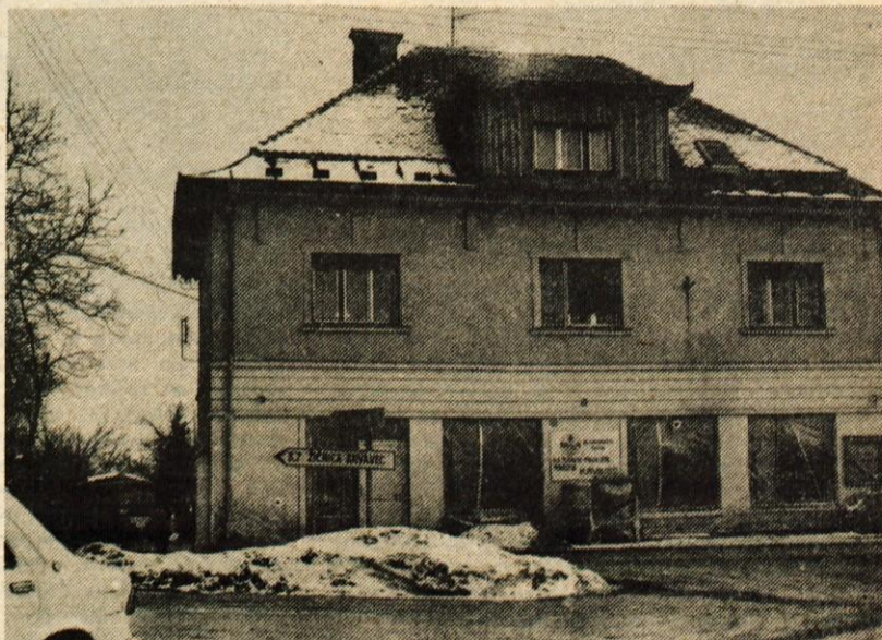
Cerklje – Pred leti je v tej stavbi že bila trgovina. Kasneje so se v opuščenih prostorih naselila Živila, ki so tu skladiščila blago. Zdaj so se lotili obnove in če se ne bo zataknilo, bodo novi prodajni prostori do pomladi useljivi. Dve prodajalni, ki sta doslej oskrbovali Cerklje in okolico, že nekaj časa ne zadoščata več, zato bo nova samopostrežna trgovina pomembna pridobitev. – Foto: D. Ž.
