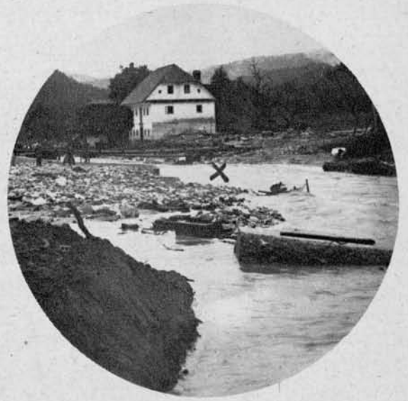
Kolodvor v Medvodah pod vodo.
