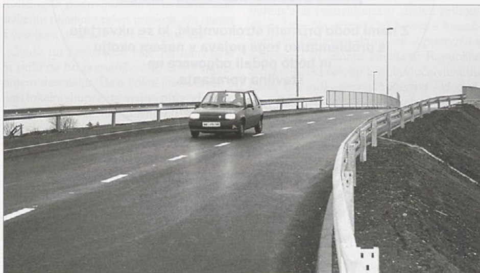
Dela na trasi AC na območju Občine Hajdina zaenkrat potekajo po terminskih planih, v sklopu tega pa so še pred koncem leta odprli dolg nadvoz v Dražencih.
