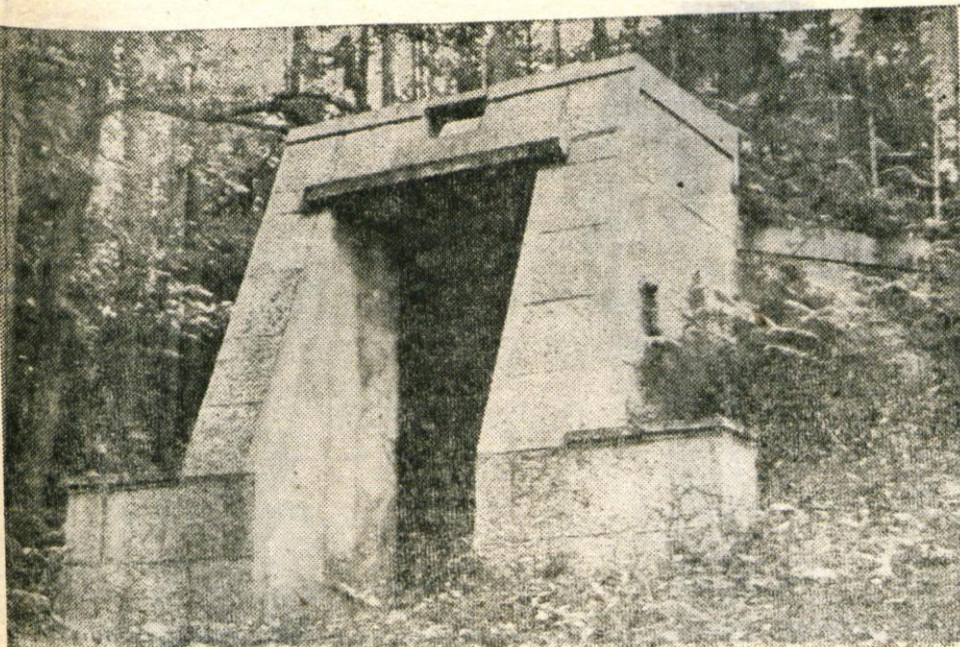
Gradnja novega vodovoda je bila ena največjih prostovoljnih delovnih akcij prebivalcev Naklega in okolice. Na fotografiji je zajetje v Strahinju. — Foto: F. Perdar
