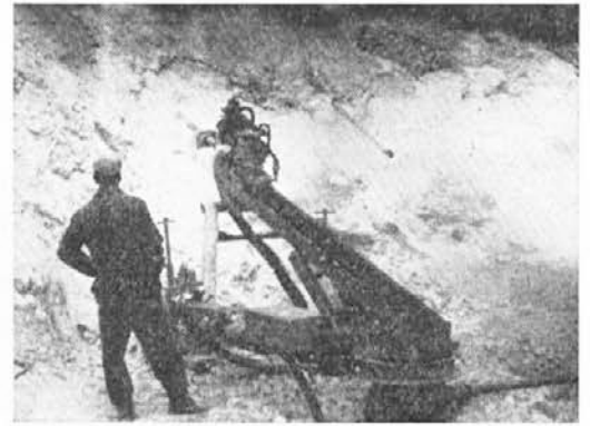
Slika 11 b — globinski vrtnalni stroj Ravne pri vzponskem vrtnanju v Lepoglavi
