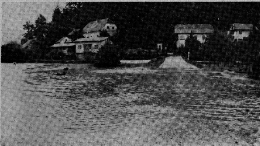
V Dobletino se z avtomobilom ni dalo. Voda je zalila cesto, ki pelje preko mostu
