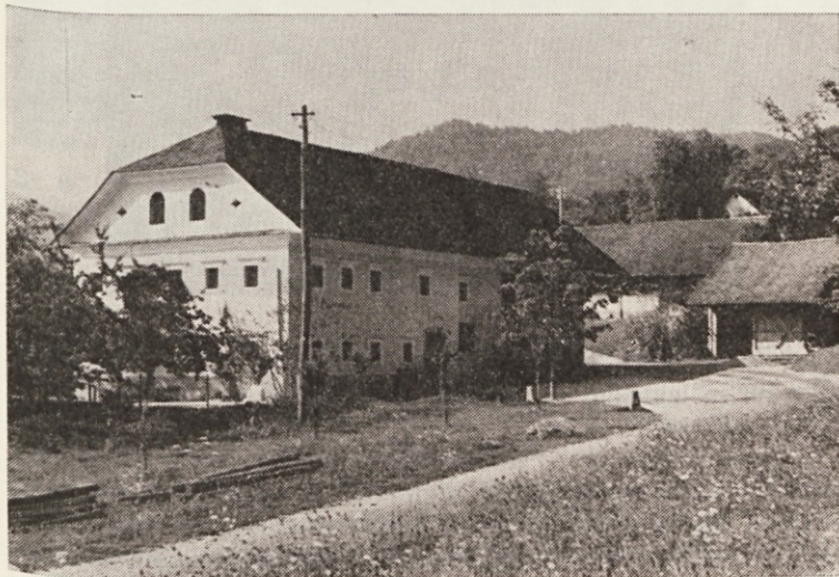
Sl. 8 — 1 in 2. Kmečki dvorec Pri Jurju. Portal je iz škofjeloškega konglomerata z letnico 1892. Starejši okniki so iz terciarnega apnenčevega peščenjaka. Baročni gautri krasijo okna. Iz arhiva šole arhitekta M. Muršiča
