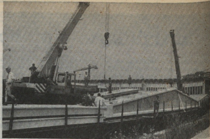
Dvokapne nosilce za halo v Luki Koper je bilo treba peljati z vlakom. Tudi vse druge elemente so naložili na vagone.
