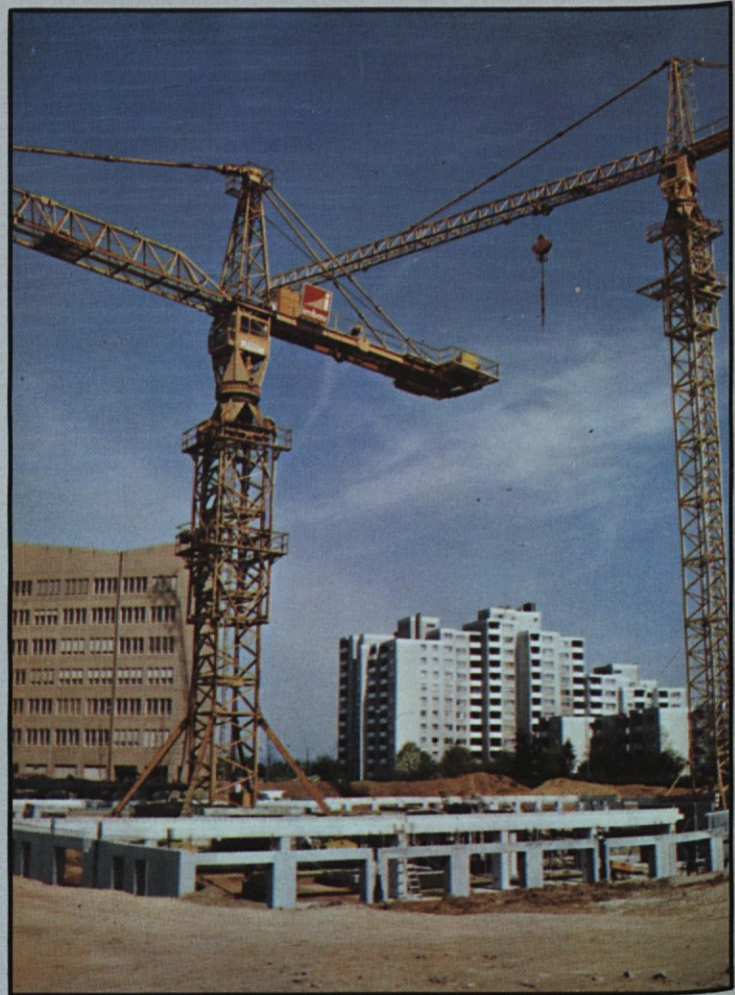
Büro Sterne – skupno gradbišče Gradisa in Imbaua v Mainzu.
