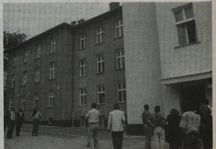
Na zunaj ni nič posebnega, notranjost pa je povsem nova.
