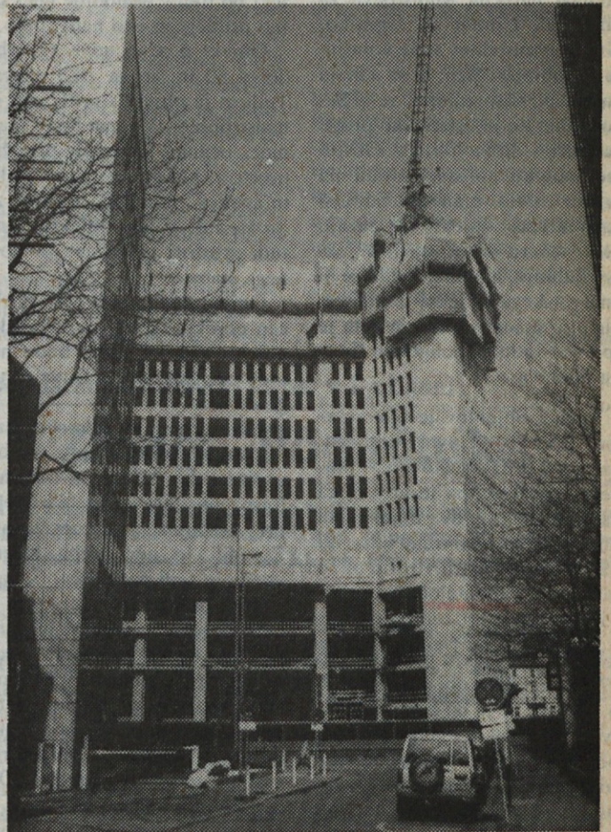
Samoplezalni opaž sistema PERI je bil sestavljen iz 53 plezajočih samostojnih enot.
