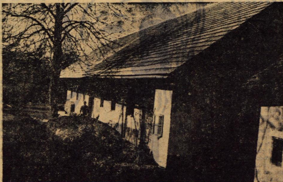
Ta hiša (Okroglo — pri Pogvajnu) ima v isti vrsti s stanovanjskimi prostori tudi hlev, nad njim pa je prostor za shrambo slame in druge krme za živino. Vzporedno s tem objektom pa je prvotno lesen pod s šupo za steljo nasproti hleva in s šupo za vozove na drugi strani — (Slika prikazuje hišo)
