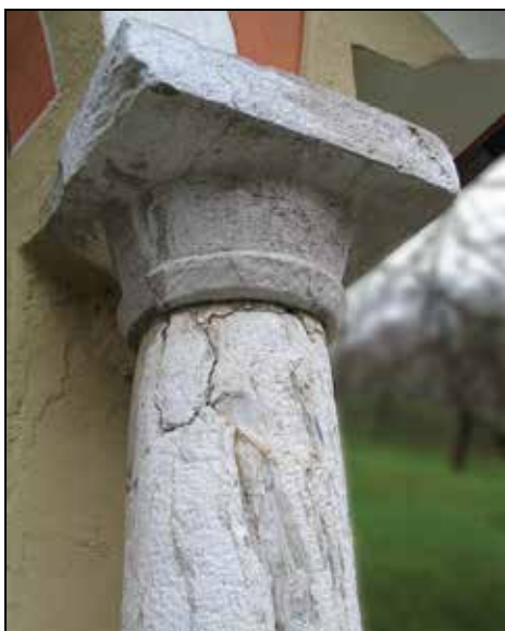
Detajl desnega kamnitega stebriča. Foto: Anton Sedej
