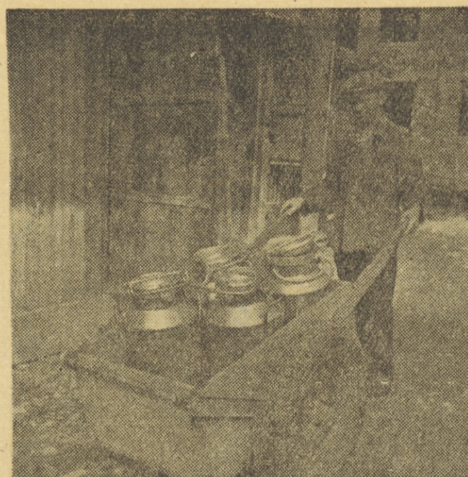
»Seveda se izplača«, pravijo gradbeni delavci, ki gradijo stanovanjski blok Mariborske predilnice in tkalnice, »delamo od šestih zjutraj pa do petih popoldne in nam topel obrok v odmoru kar tekne!« Malico vozijo na gradbišče iz obrata družbene prehrane v Mariboru in obrok stane 40 dinarjev.
