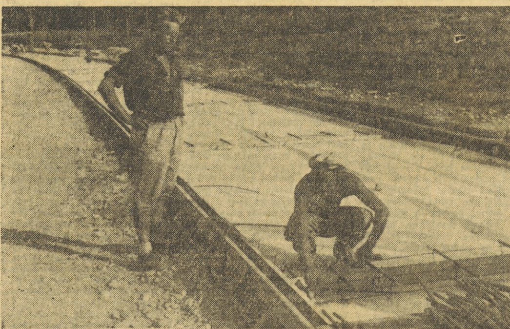
37 dni pred rokom je izvršil svojo nalogo delovni kolektiv Gradisa na avtomobilski cesti pri Krškem: tretjega oktobra so zabetonirali zadnji meter cestniša na tem odseku. Ta kolektiv je prevel še betoniranje treh in pol kilometrov vozišča in osem kilometrov robnega pasu. Na »likofu« so obljubili, da bodo tudi novo nalogo opravili pred rokom!
