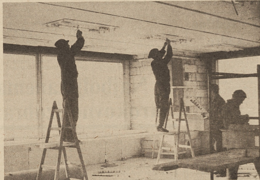
Delavci Elektromontaže opravljajo vsa elektroinstalacijska dela
