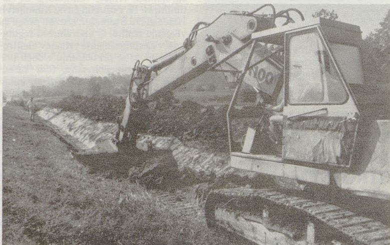
Letos so stroji opravili gigantska dela pri urejanju melioracij in namakalnih naprav. Kmalu se bodo začela velika namakalna dela na polju od Letuša do Pariželj.
