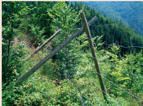
Slika 22: Škarjasta postavitev samonosne žične ograje
