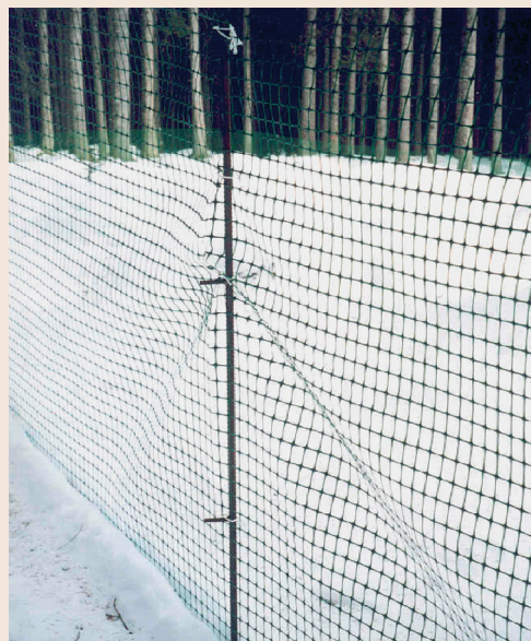
Slika 21: Zaščitna ograja iz kaljene plastike in z železnimi nosilci.
