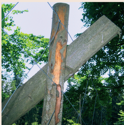
Slika 23: Konstrukcija in vpetje škarjastega nosilca na vrhu
