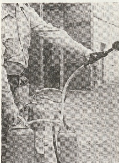
Ročni gasilni aparat na vodo z razpršilcem.
