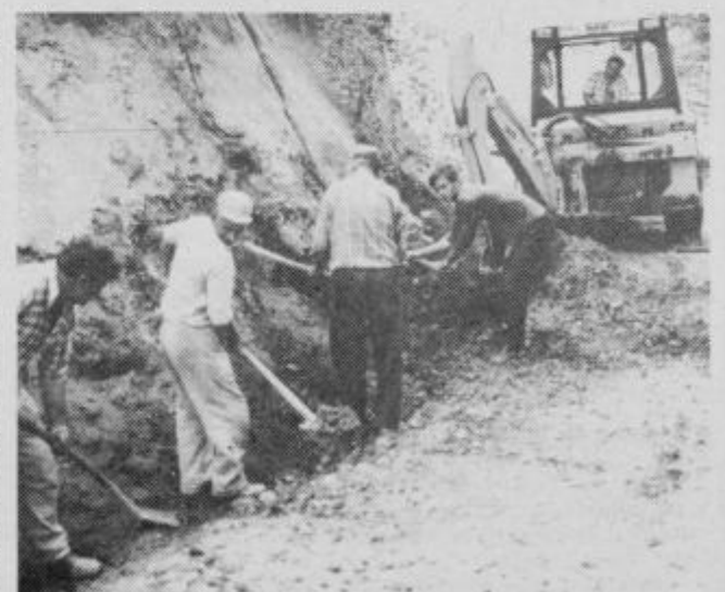
Med gradnjo ceste v južni Podvrh
