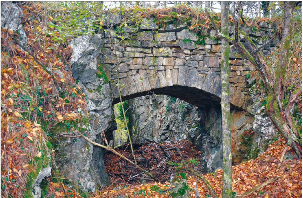
Slika 4: Del Liletove kave (kamnoloma) z galerijo danes. Slika 5: Suhozidni most čez žleb, po katerem je potekala štreka (ozkotirna proga).
