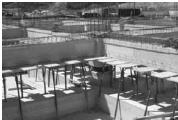
Slika 3: Tehnična etaža potrebuje vsaj 1,5 m višine. [Clemente, P.: Isolamento sismico della nuova scuola F. Iovine di San Giuliano di Puglia (str. 4), http://www.assisi-antiseismicsystems.org/Territorial/GLIS/Applicazioni06.htm , <april, 2007>.]
