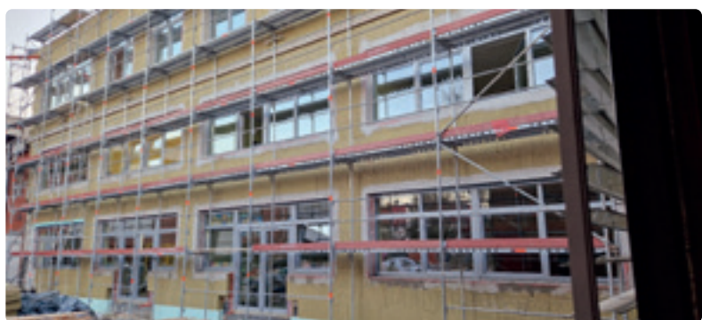
Slika 7: Obloga na vzhodni stene šole (vključno z nadzidkom) (3. 2. 2023)
