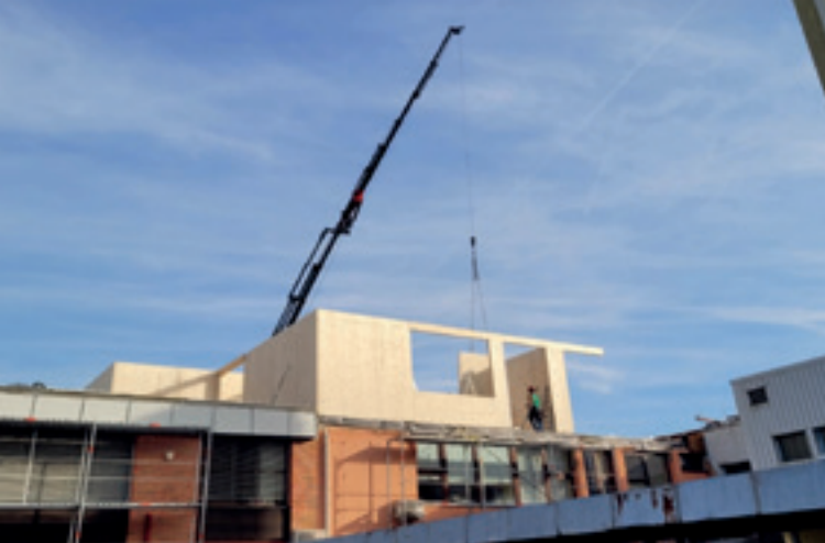
Slika 4: Postavitev nadzidka (2. 11. 2022)
