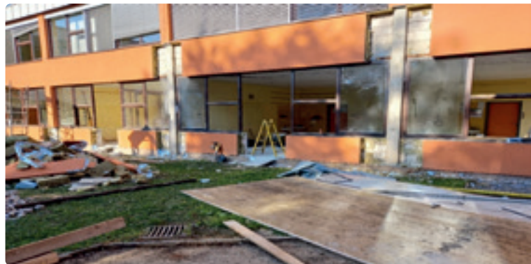
Slika 1: Odstranitev oken in priprava prostorov za ojačitev temeljev in stebrov (2. 9. 2022)
