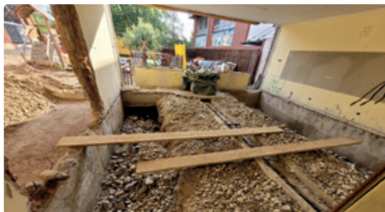
Slika 2: Izkop temeljev za ojačitev zgradbe – pogled od znotraj (24. 9. 2022)
