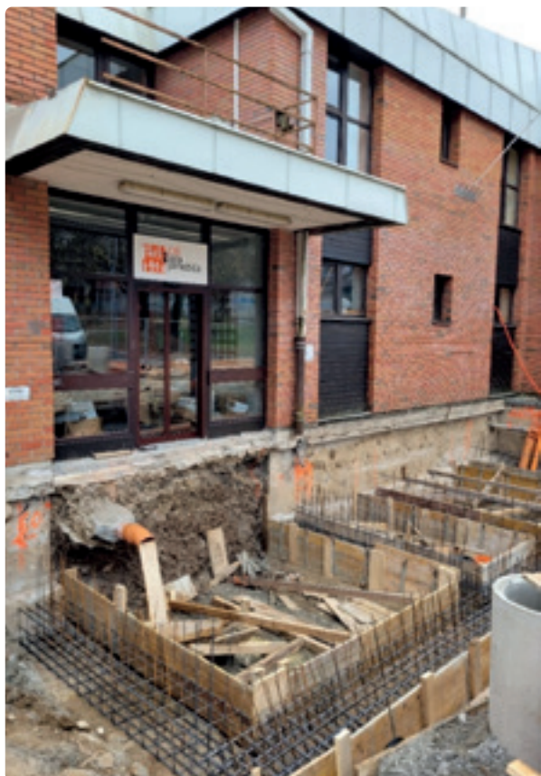
Slika 5: Izkop pred glavnim vhodom za menjavo kanalizacije in nove plošče pred vhodom 21. 11. 2022
