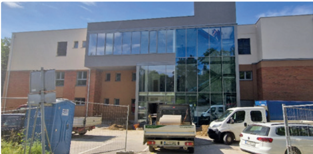
Slika 19: Pogled na šolo s severne strani (konec junija 2024)
