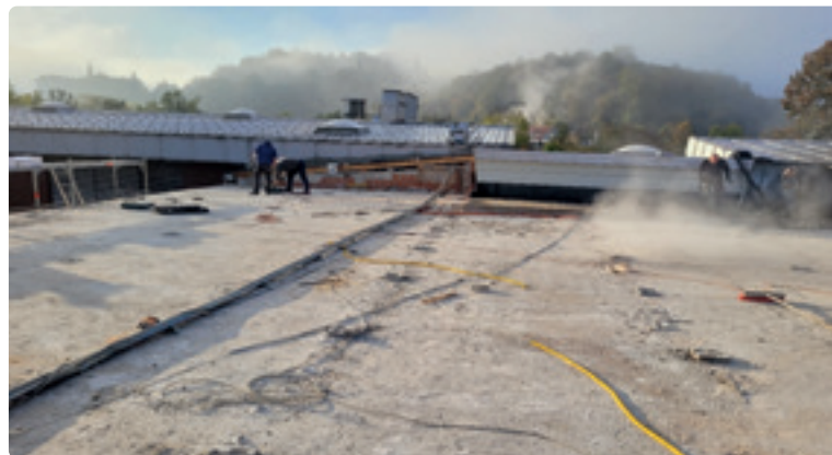
Slika 3: Priprava strehe za betoniranje (Potrebno je bilo zvrtniti 3000 lukenj.) (19. 10. 2022)
