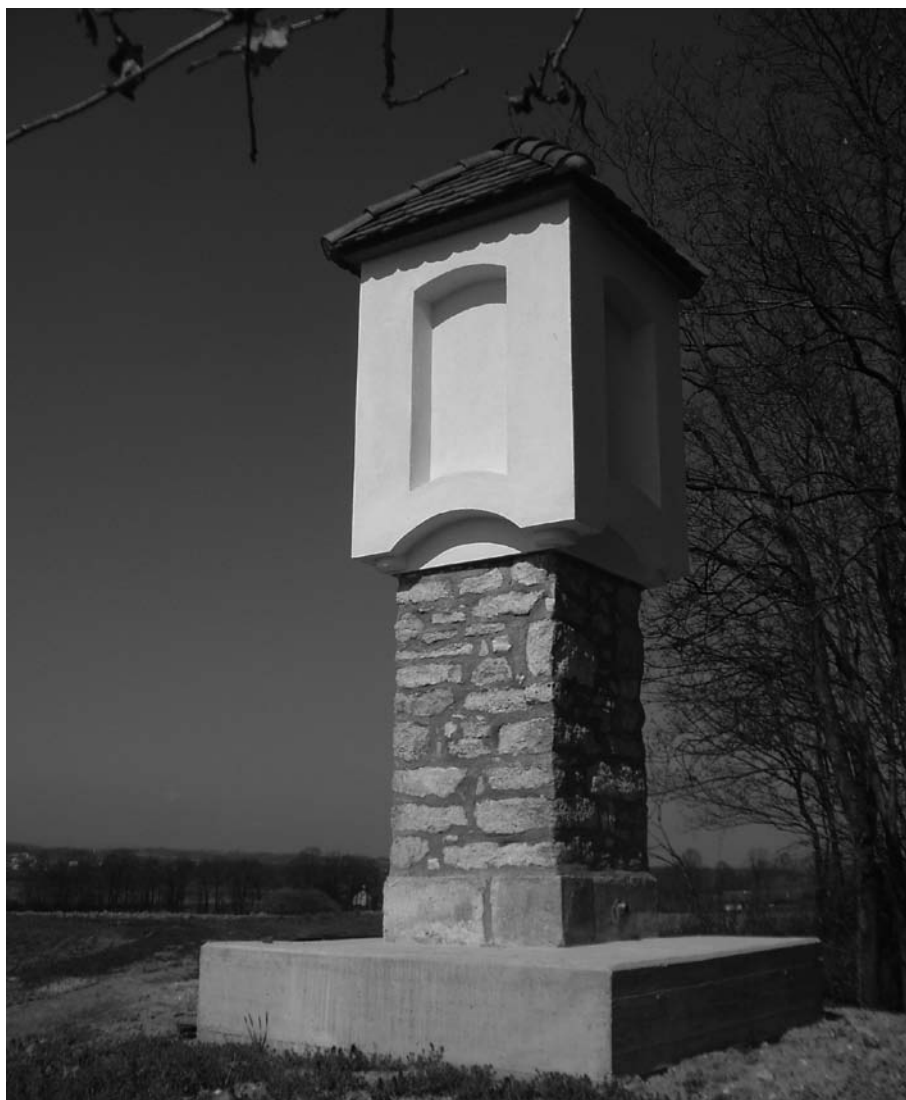
Drage po obnovi.
