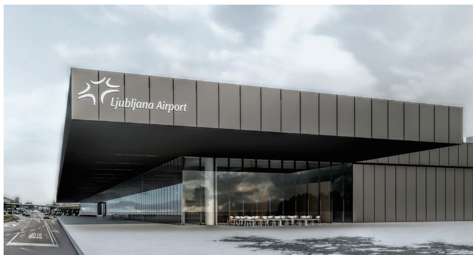
Slika 2 • Nadstrešek vzdolž celotnega novega dela terminala.
