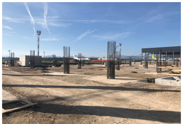
Slika 13 • Armatura AB-stebrov v pritličju.
