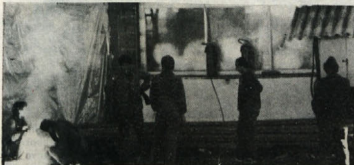
V Beti se poleg redne proizvodnje zmeraj kaj dela. Enkrat je treba preurediti vhod, drugič se je treba spraviti nad skladišča. Pričujoča slika prikazuje delo pri obnovi skladišča v TOZD metraža. (Foto: Branko Matkovič)
